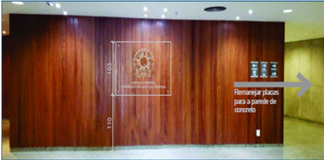
VISTA FRONTAL DA PAREDE DE INSTALAÇÃO DA PLACA
