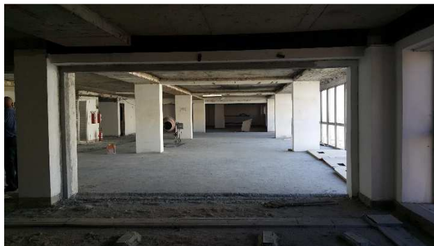
Execução parcial de contrapiso
