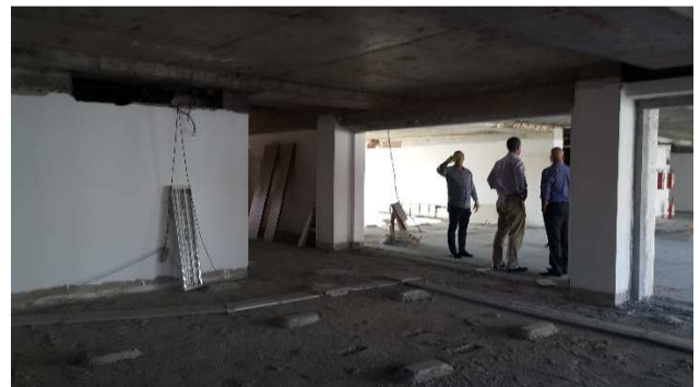
Execução parcial de contrapiso
