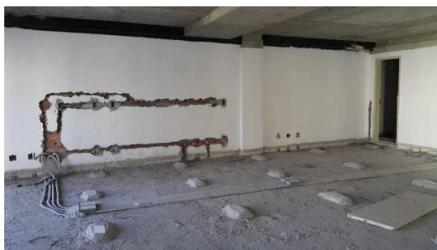
Rasgos em alvenaria para passagem de eletrodutos
