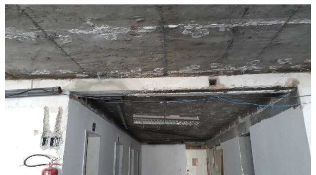
Detalhe das vigas após a recuperação
