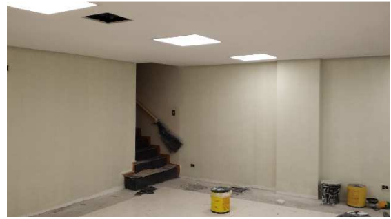
Pintura, forro de gesso e luminárias concluídos
