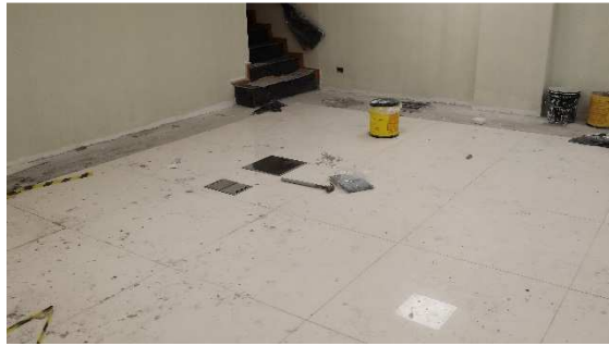
Piso de porcelanato e acabamento da escada concluídos
