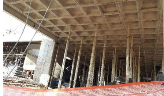
Escoramento da laje central do segundo piso
