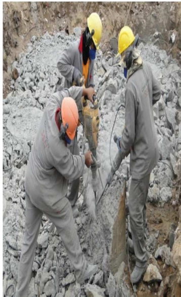
Arrasamento das estacas para realização do ensaio tipo PIT.
