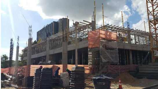
Vista da obra
