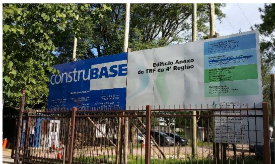
Placa de identificação da obra no acesso principal
