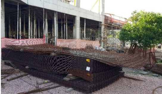
Montagem de forma e distribuição do aço da laje do segundo piso
