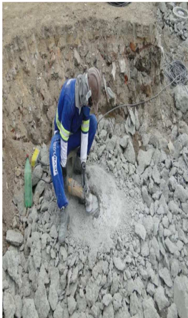
Arrasamento das estacas para realização do ensaio tipo PIT.
