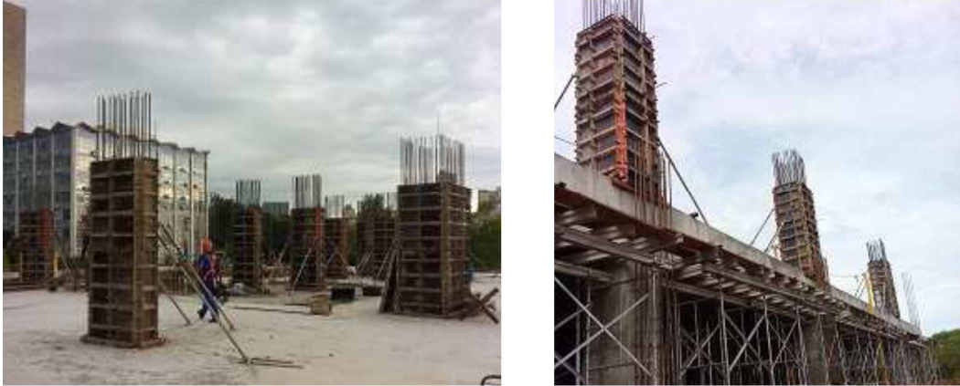
Montagem de forma e aço dos pilares
